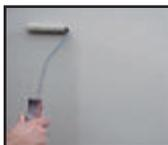
1. Для подготовки – обеспыливания и выравнивания водопоглощения - минеральных поверхностей (цементных поверхностей, гипсовых, цементных, штукатурок, ГКЛ, ГВЛ, ДСП панелей) обработать поверхность грунтовкой глубокого проникновения **PRIMER С**. Краску или лак удалить, поверхность обработать грунтовкой **PRIMER С**. Уже существующие поверхности с керамической или мозаичной облицовкой обезжирить, промыть чистой водой и высушить.
