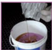
5. Нанесение основы - двухкомпонентного эпоксидного состава **DECOR PRIMER FONDO** обеспечивает получение белой, прочной поверхности с одинаковой степенью водопоглощения, идеально подходящей для нанесения **STARLIKE DECOR**.
