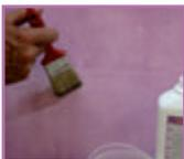
13. Через 3-4 часа нанесите следующий слой, проделывая ту же процедуру, либо используйте зубчатый шпатель для получения рельефной структуры. Структура зависит от типа шпателя.
