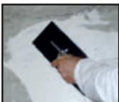
2. Если **STARLIKE DECOR** предполагается наносить на основания - цементные, гипсовые штукатурки, ГКЛ, ГВЛ, ДСП, деревянные панели - необходимо предварительно нанести на их поверхность базовое двухкомпонентное эпоксидное покрытие **DECOR PRIMER FONDO**.
