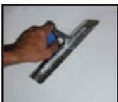
3. **DECOR PRIMER FONDO** - двухкомпонентный эпоксидный состав белого цвета, готовится смешиванием двух компонентов. В ведро с белой пастой (компонент А) выливается жидкий отвердитель (компонент В) и перемешивается с помощью дрели с насадкой. Готовый пастообразный состав **DECOR PRIMER FONDO** наносится на поверхность с помощью гладкого шпателя ровным слоем, толщиной около 1 мм.
